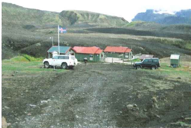
Mynd 6.1 – Aðkoman að Emstrum frá norðri. Horft í átt að Mýrdalsjökli og skálavarðarhús næst (efst).
