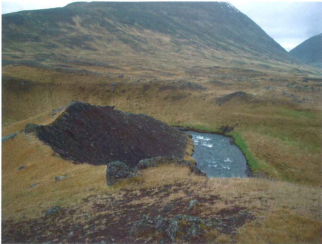
Fyrirhugað stíflustæði. Hryggurinn sem sést á myndinni verður framlengdur yfir ána. Yfirfallið og inntakið mun verða á hryggnum.
