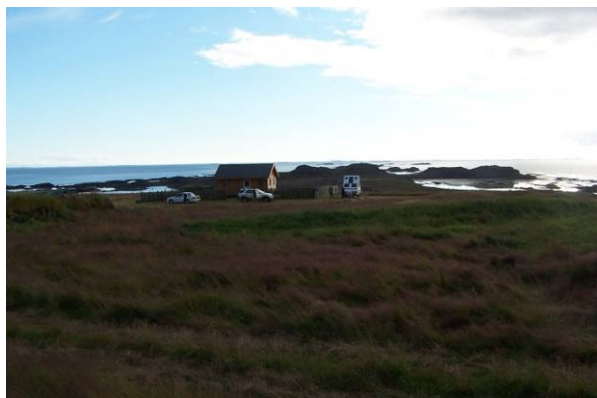
Mynd 6. Frístundahús Skálarnesi.
