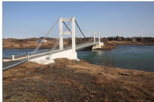
Mynd 16. Hvítárbrú við lðu.
