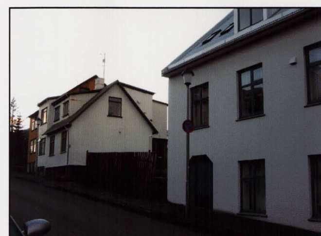
FRAKKASTÍGUR - HORFT Í SUÐVESTUR
