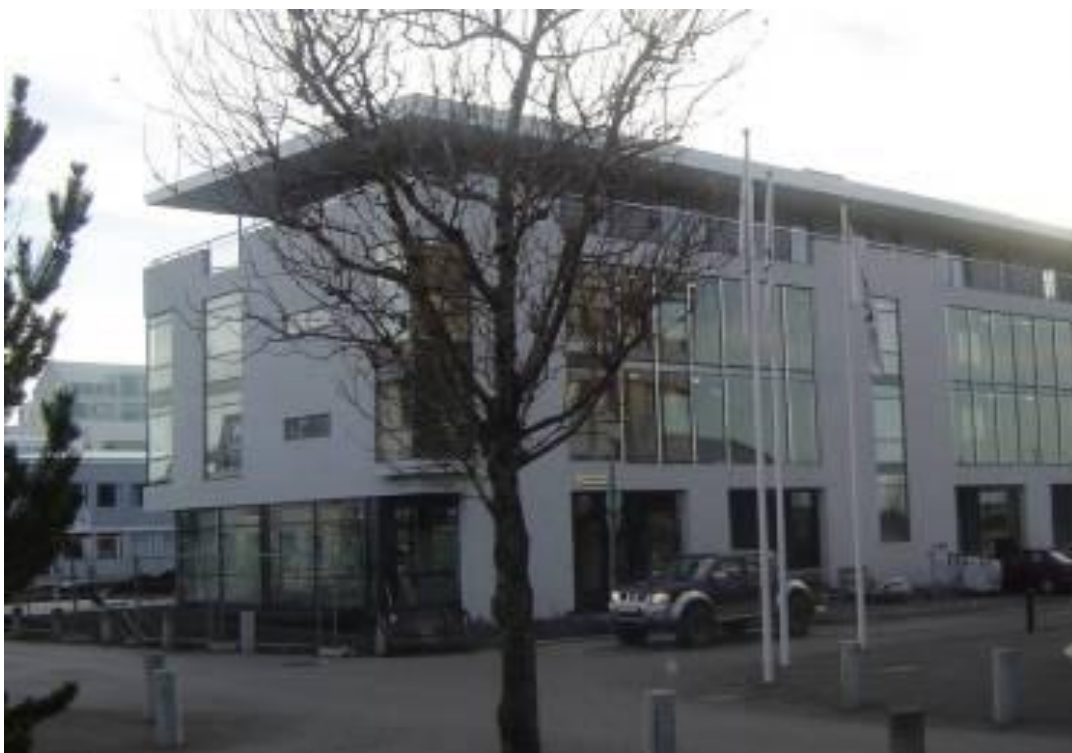
Nýleg bygging í miðbæ Hafnarfjarðar
