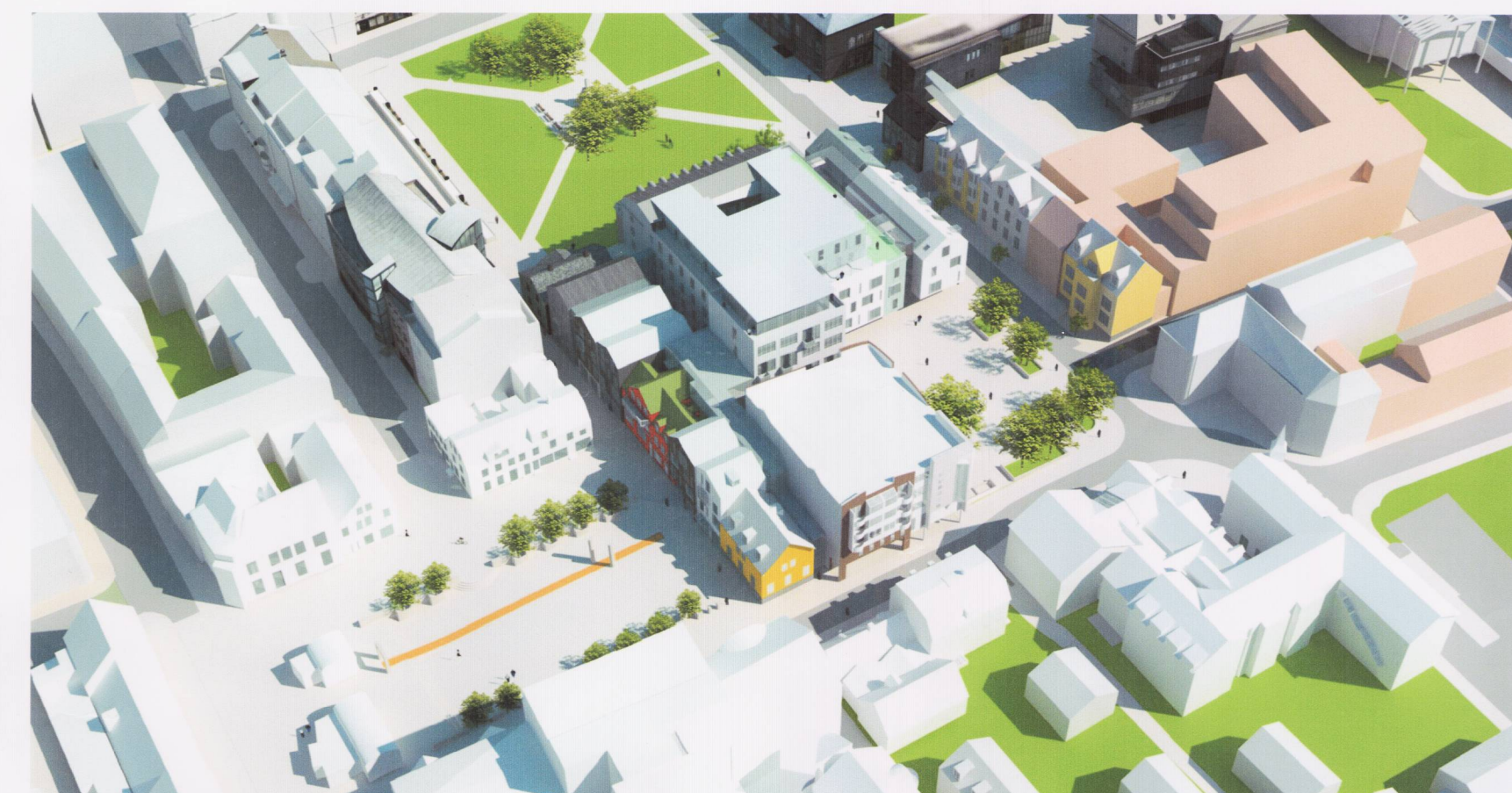
Yfirlitsmynd - horft til suðurs
