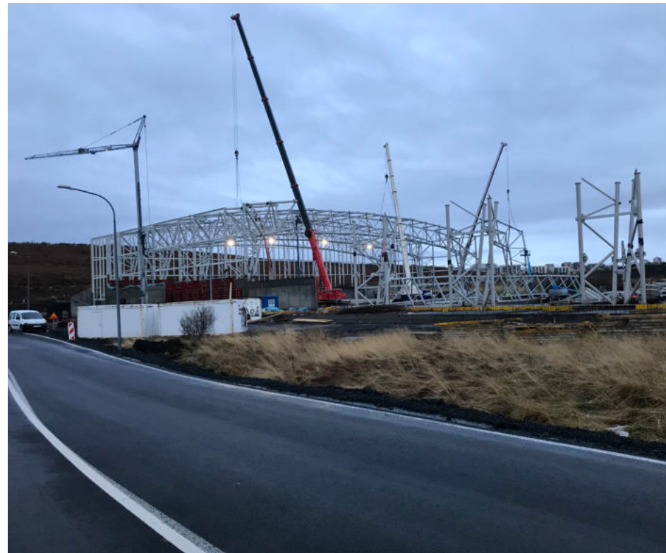
fjölnota íþróttahús í byggingu skv. eldra skipulagi
