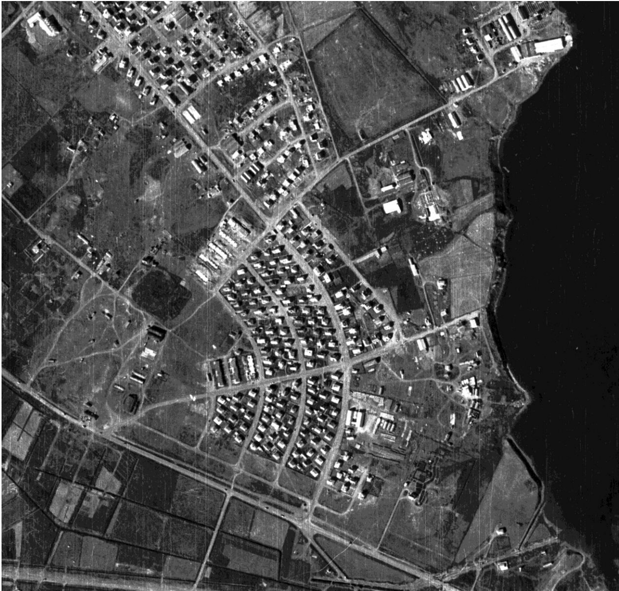
Mynd 25 Svæðið austan Elliðaársvogs á loftmynd frá 1954. Atvinnu- og iðnaðarhúsnæði er byrjað að rísa á iðnaðarsvæðinu sem seinna var afmarkað til vesturs af götunni Elliðavogi (Sæbraut), meðal annars hús Rafmagnsveitna ríkisins , niðursuðuverksmiðjunnar Mata hf. og Glersteypunnar hf. (sjá einnig mynd 25). 141
