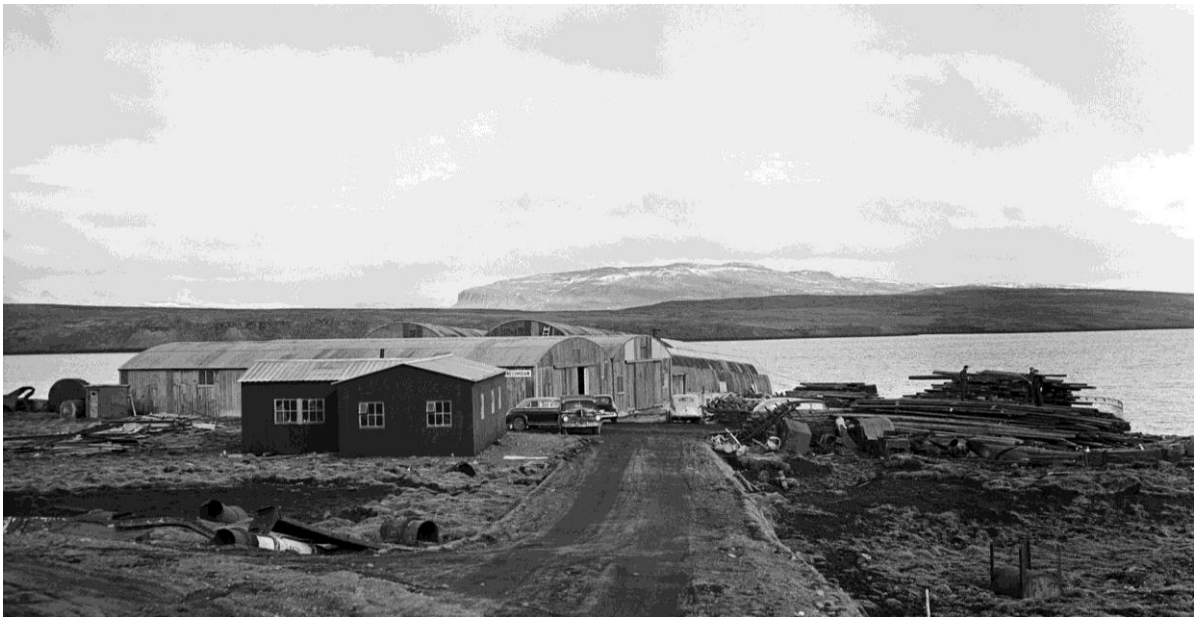
Mynd 17 Hús Landssmiðjunnar á Gelgjutanga á ljósmynd frá 1946. Fremst er verkamannaskýli en fyrir aftan sjást bogaskemmur sem reistar voru á lóðinni á árunum 1945-1946 undir skipasmíðar fyrirtækisins. 99
