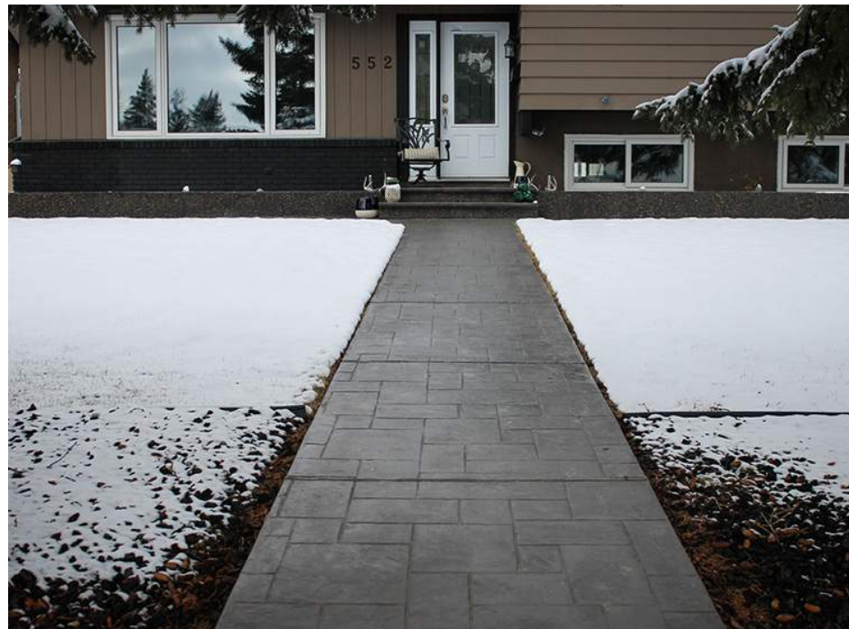
snjóbræðsla getur víða verið nauðynleg í bröttu landi
