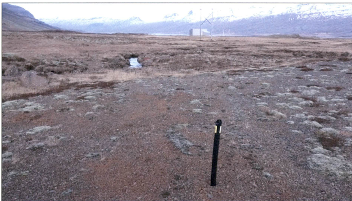
Mynd 6. Horft til norðurs eftir fyrirhugaðri lagnaleið þar sem ljósleiðari mun sveigja frá vatnslögn að tengivirki. (Ljós. Andrés Skúlason).
