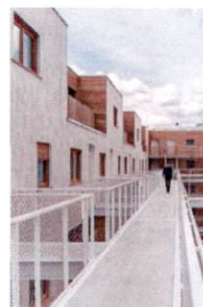
Húsför og útlit - svalagangar
