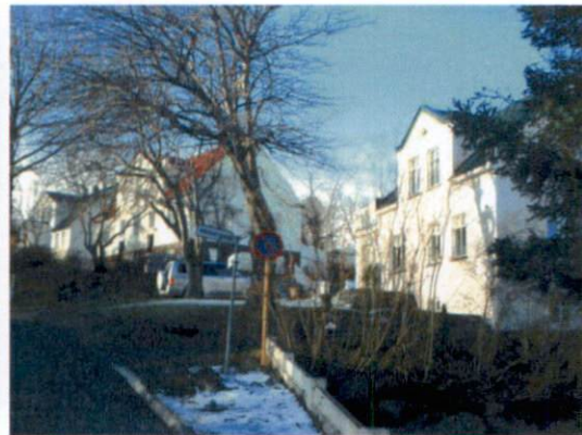
Mynd 22. Hamarstígur 2-6. Ljósmynd B.J.
