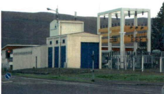
Mynd 31. Spennistöð Akureyrar. Arkitekt Sigvaldi Thordarson. Ljósmynd B.J.
