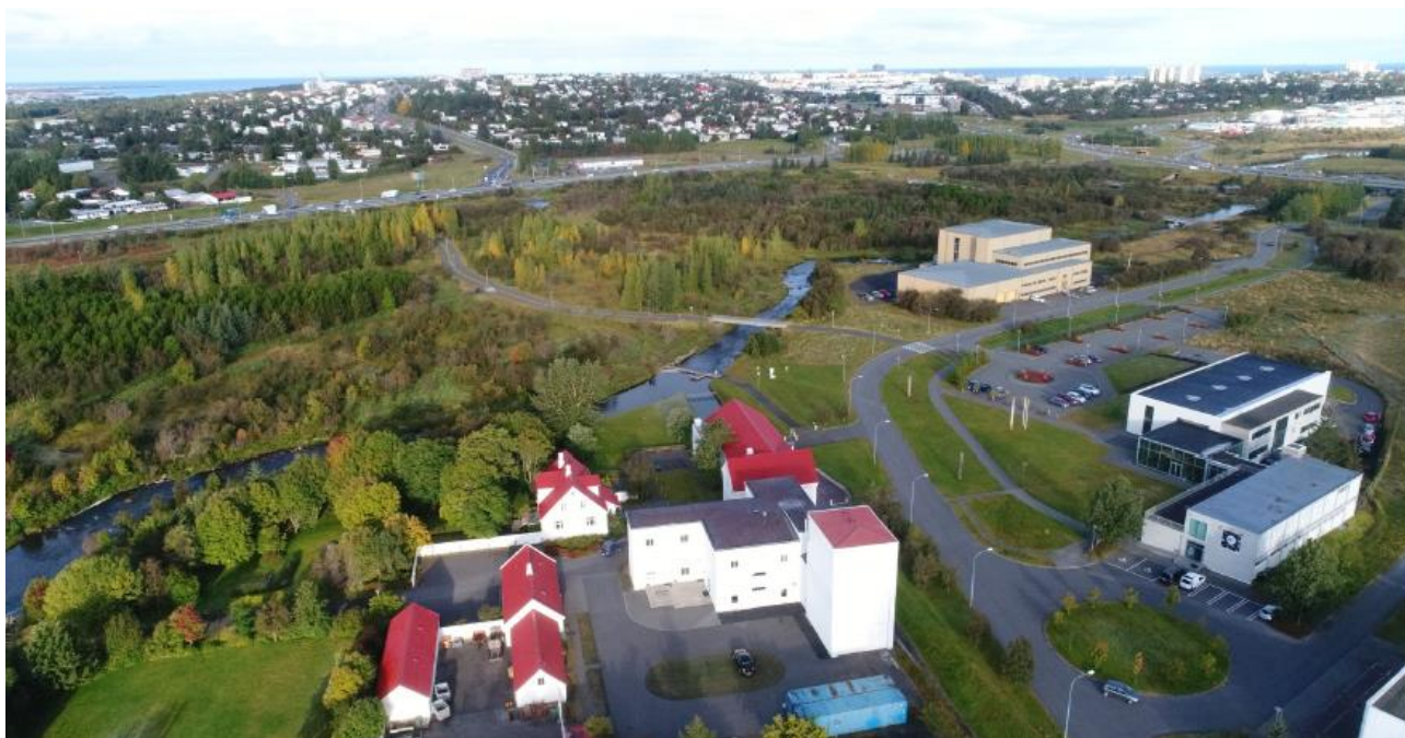
Mynd 2. Toppstöðin fjærst, nýjar byggingar sem nú hýsa skrifstofur til hægri og Gamla Rafstöðin fyrir miðju.
