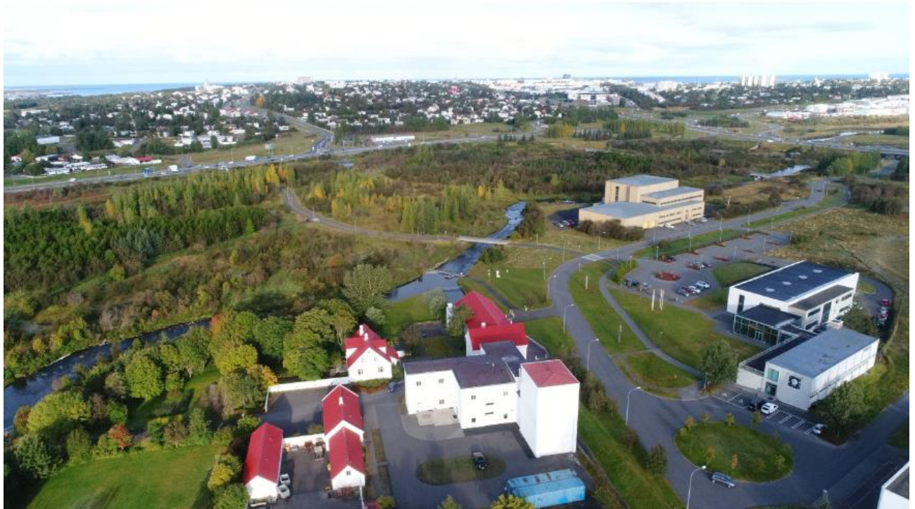
Mynd 10. Toppstöðin fjærst, nýjar byggingar sem nú hýsa skrifstofur til hægri og Gamla Rafstöðin fyrir miðju
