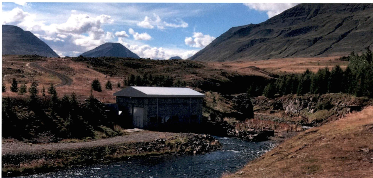
Mynd 4. Stöðvarhús Djúpadalsvirkjunar I.
