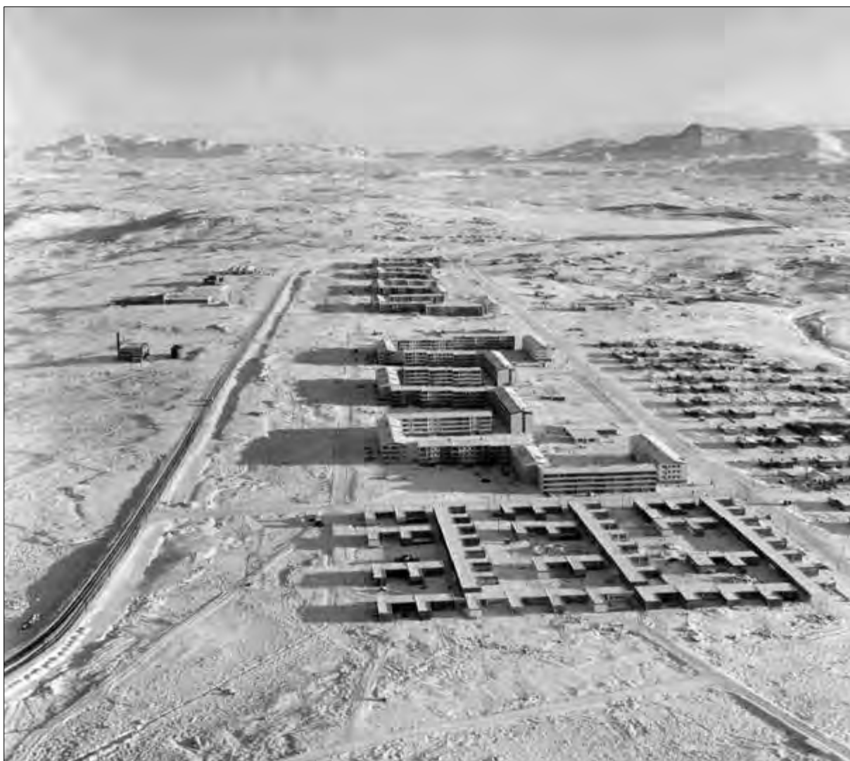
Mynd 40 Séð yfir Árþégarhverfi nýbyggt árið 1968, blokkir við Hraunbæ og íbúðarhús sunnan Rofabæjar (gamla Suðurlandsvegur). Vinstra megin er nýr vegur sem leysti gamla Suðurlandsveg af hólmi (núverandi Bæjarháls). Vinstra megin við hann eru kaffibrennsla O. Johnson & Kaaber og þvottahús ríkisspítalanna. 147
