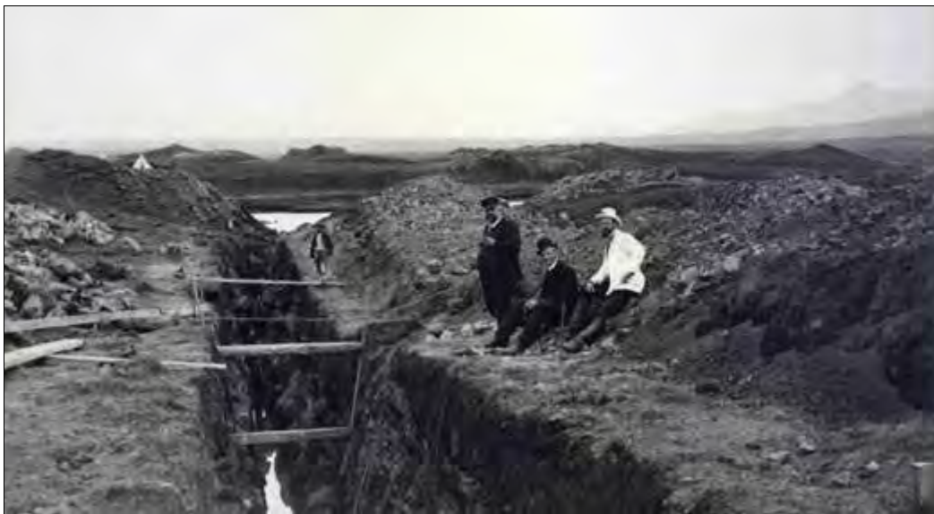
Mynd 17 Lagning vatnsveitunnar 1908 eða 1909. Yfirverkfræðingur framkvæmdanna, H.A. Hansen, stendur við skurðinn, en við hlið hans situr Knud Zimsen, þáverandi bæjarverkfræðingur Reykjavíkur. Í baksýn sjást Rauðhólar. 73
