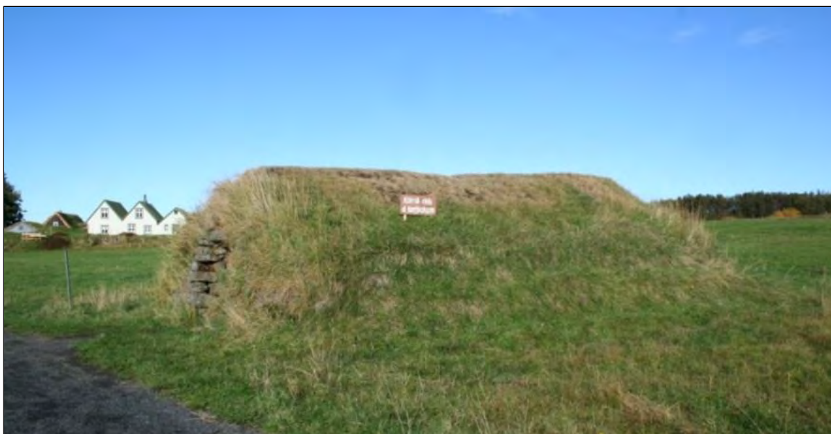
Mynd 88 Fjánhús 262-6 austan við Árbæinn, horft í norðvestur. Inngangur snýr í suður.
