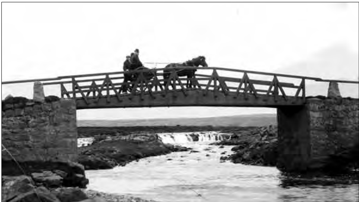
Mynd 50 Brúin yfir vestari kvíslina um 1910. Í baksýn er Búrfoss. Brúargólf og handrið úr timbri. 175
