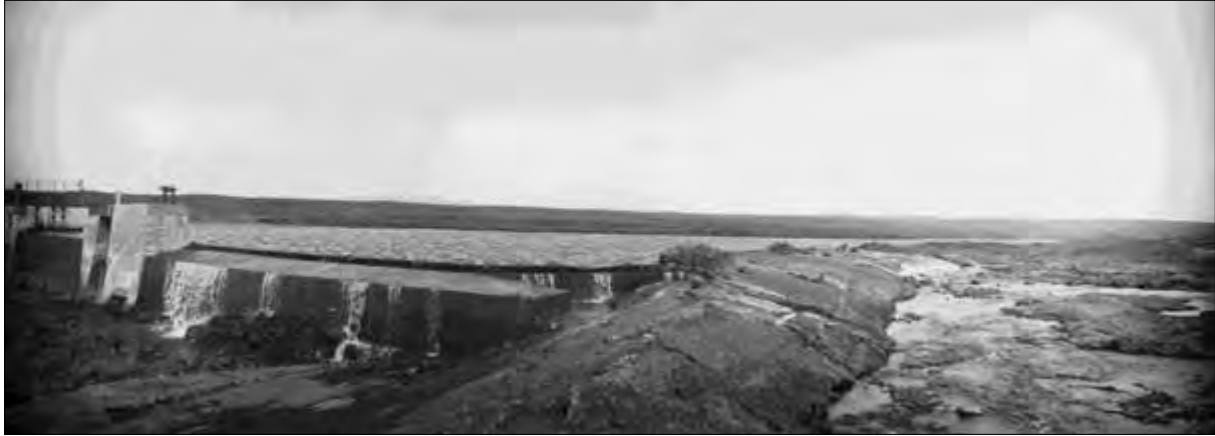
Mynd 20 Árbæjarstífla nýbyggð á mynd frá 1921-1925. Hér nær hún einungis yfir norðurkvísl Elliðaáanna að Blásteinshólma og hefur ekki verið lengd yfir suðurkvísl ána. 84
