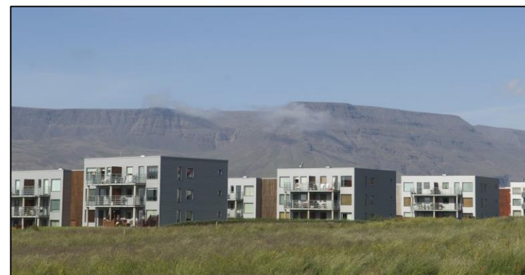
Mynd 4.7 Fjölbýlishús við Klapparhlíð.
