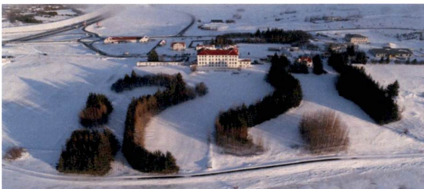
MYND 47 Flugmynd, horft til norðurs yfir Vífilsstaði, skróðgarð og Hraunsholtslæk. Vetrarmýri í fjarska.
