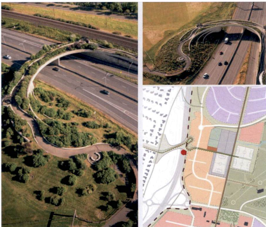
MYND 45 Til vinstri og efst til hægri: Jarðbrú í Vancouver, Kanada. Neðri mynd til hægri: úrklippa úr skýringarmynd sem sýnir hvernig jarðbrú tengir svæðin austan og vestan Reykjanesbrautar saman og skapar öryggi fyrir óvarða vegfarendur.
