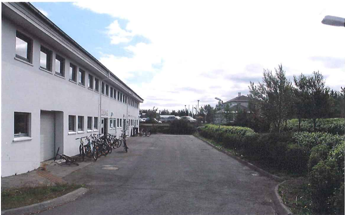
Mynd 7. Suðurhlið Pakkhússins
