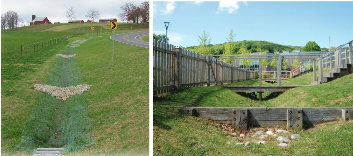
Mynd 16: Stíflur í ofanvatnsrásum sem draga úr vatnshraða og auka þannig sitrun og hreinsun ofanvatns (Massachusetts Clean Water Toolkit, á.á.; Woods Ballards o.fl., 2015).
