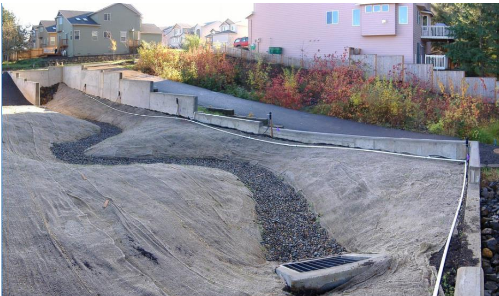
Mynd 17: Ofanvatnsrás sem hlykkjast um landrýmið. Ath. mynd sýnir ekki fulltilbúna ofanvatnsrás (Án höfundar, á.á.).
