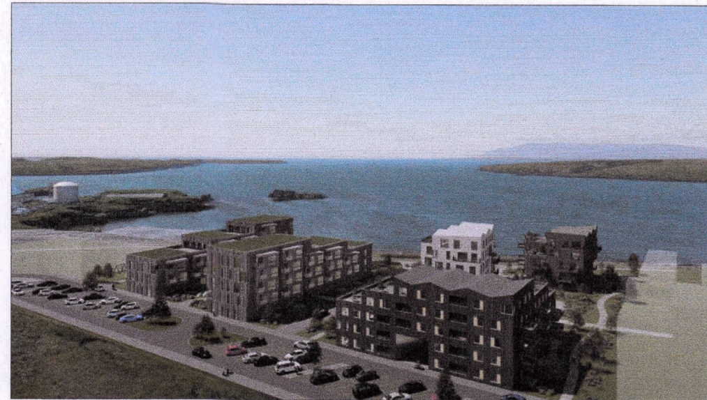
Skýringarmynd - horft yfir skipulagssvæði
