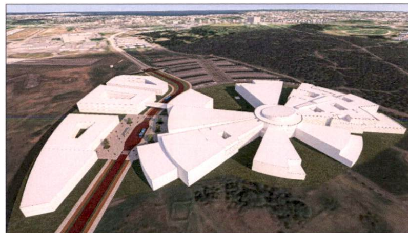
Delliskipulagssvæðið horft til norðurs
