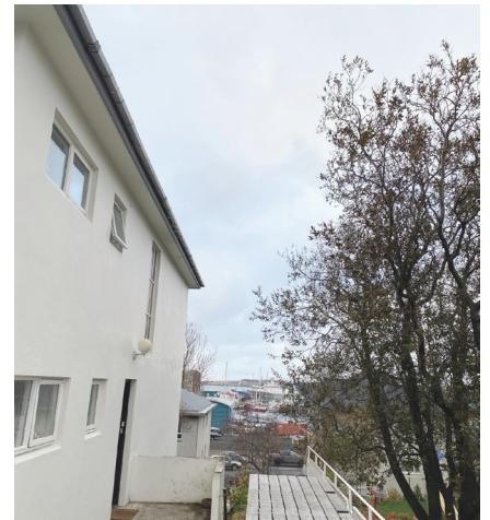
Horft á milli Suðurgötu 66 og 68
