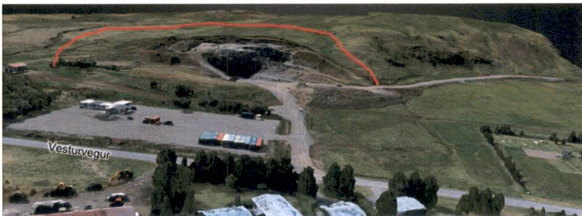
Mynd 2. Mynd sem sýnir Skaganámu frá Vesturvegi. Rauðlína sýnir umfang fyrirhugaðrar stækkunar. Mynd: Efla.
