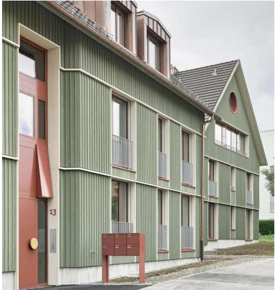
Áhugaverðir inngangar, fjölbreytt þök og litríkar framhliðar
