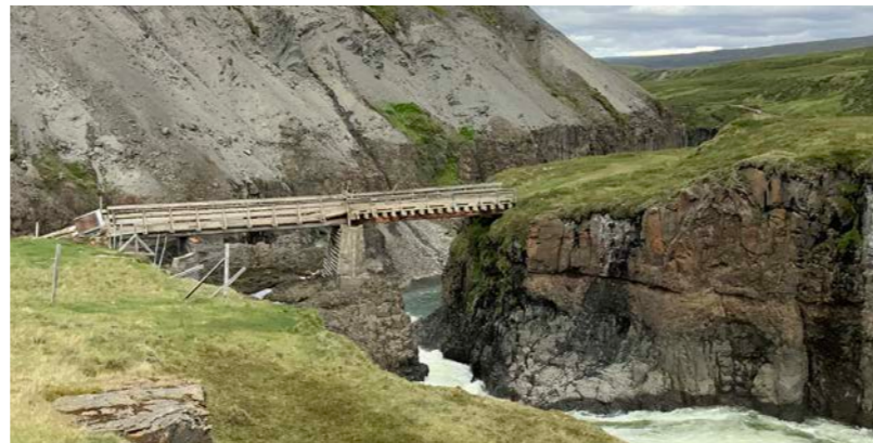
Mynd 2.10 Brú yfir Eyvindará nærri Stuðlagili.
