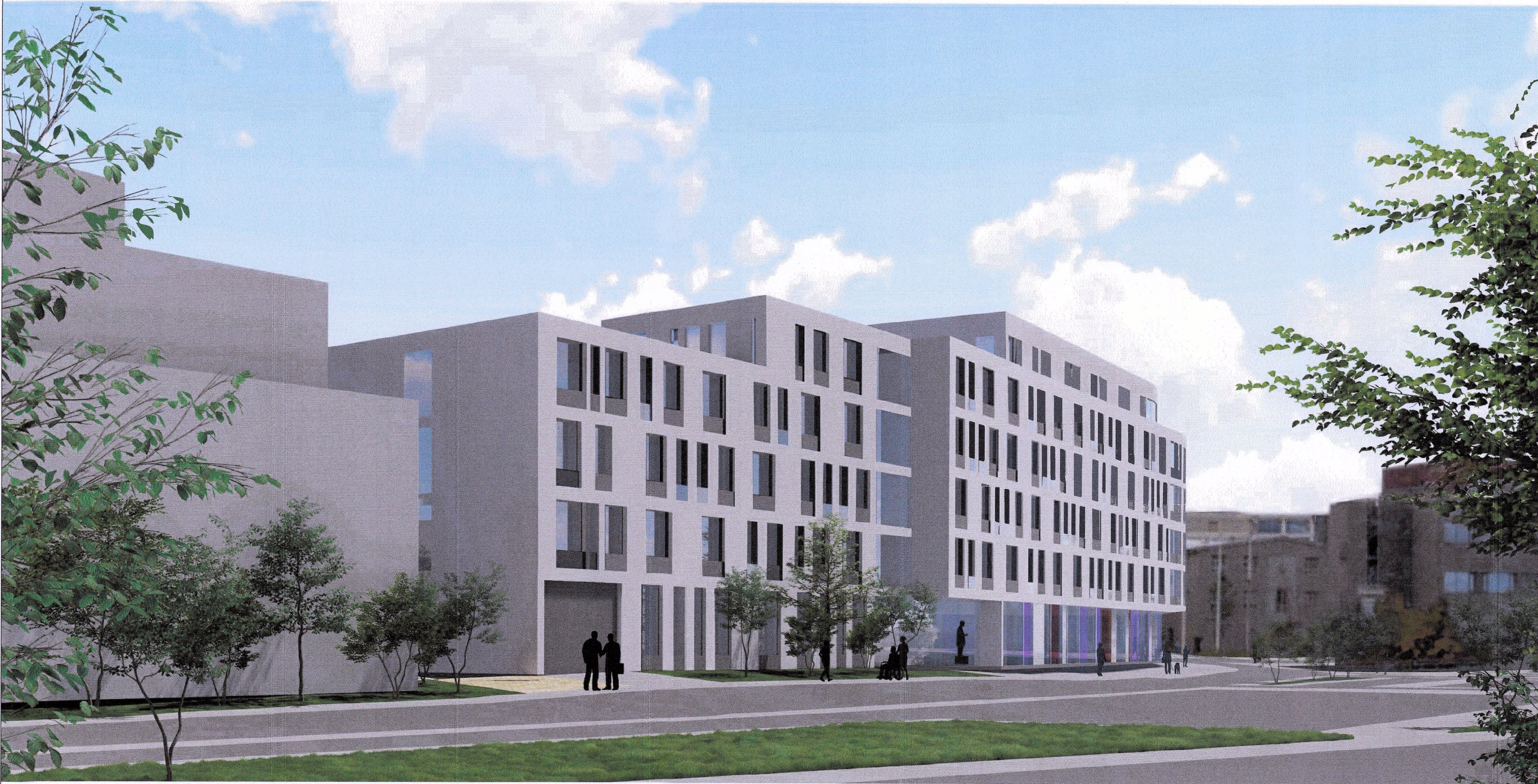
Hótelbygging við Guðrúnartún - horft til vesturs
